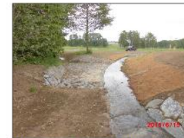
Bild 5: Kurz nach Fertigstellung: Schullwitzbach mit Abstieg zum Rosinendorfersee, Blick stromab, Juni 2016
