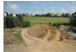
Bild 5: Während der Maßnahme: Aufschüttung und Verlichtung des Dammkörpers
