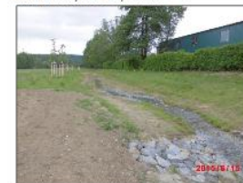
Bild 6: Kurz nach Fertigstellung: Schullwitzbach, Blick stromab, Juni 2016
