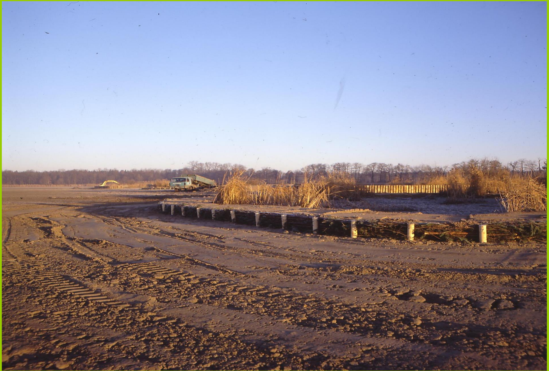
Anlage von Inseln, Flachwasserbereichen und Vegetationsschutz, Großteich 2003
