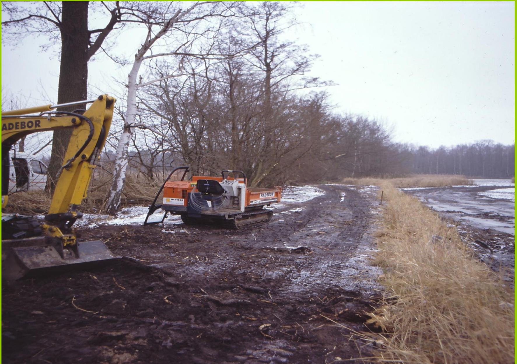
Dammbau und Anlage von Flachwasserbereichen, Großteich 2004
