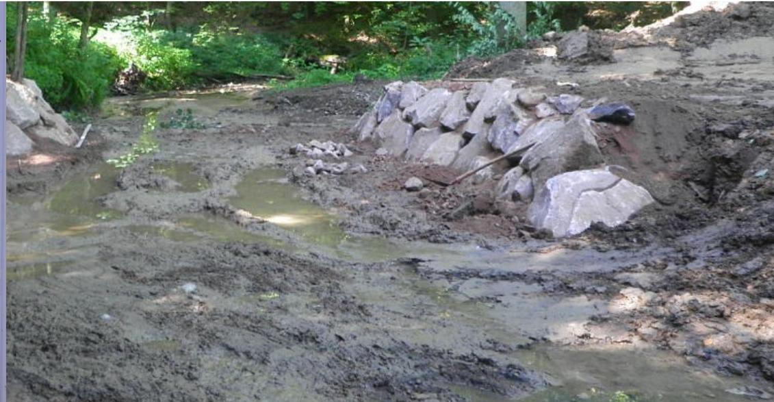
Rückbau eines Absturzes, einer Brückenverrohrung und des Uferverbaus am Auenbach (Fotos: uWB Landkreis Mittelsachsen)
