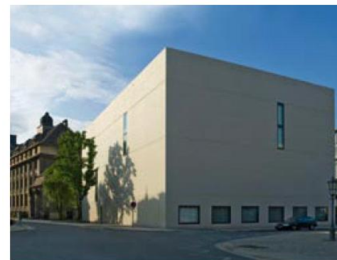
Neubau Hauptstaats- archiv in Dresden
