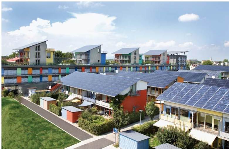
Solarsiedlung „Sonnenschiff“ in Freiburg von Rolf Disch
