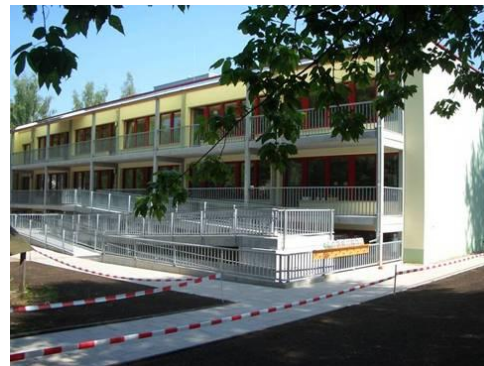
Sanierung Plattenbau-Kita in Chemnitz
