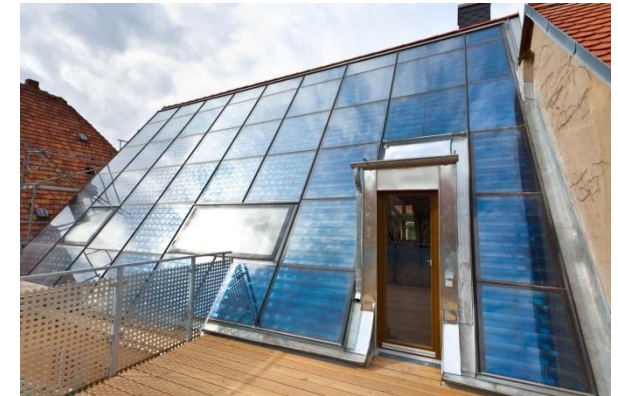
Sanierung MFH in Freiberg
